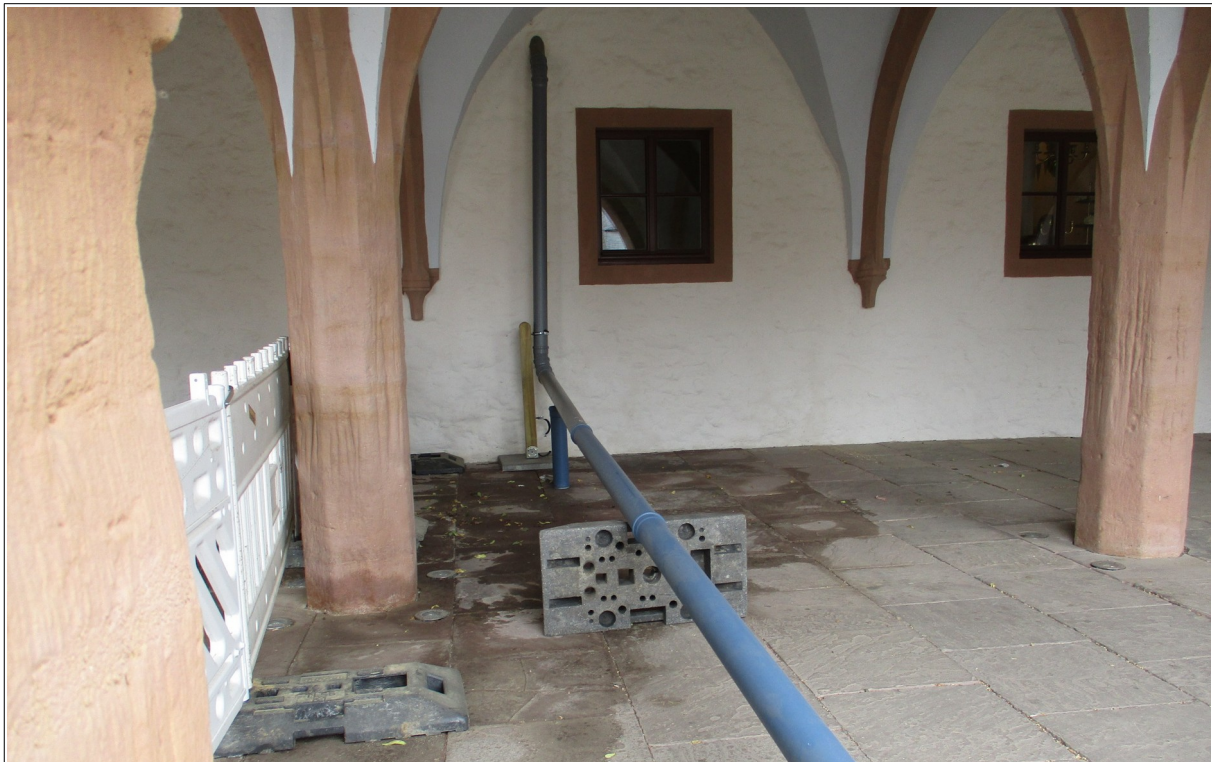
Bild 2: Die Ableitung des Regenwassers aus dem sog. Lichthof ist eine ständige Schwachstelle, wenn nicht eine regelmäßige Wartung der Rinnen und Fallrohre erfolgt. Im Schadensfall tritt das Regenwasser über den Belag der Rathaus-Arkaden in den Keller ein – wie hier im Juni 2025.
