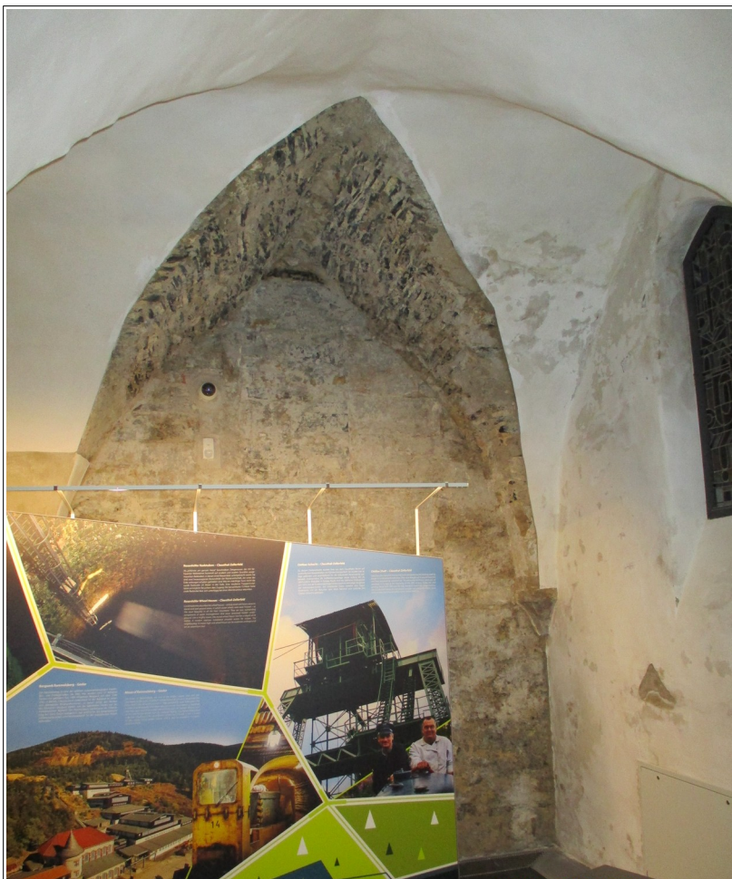
Bild 1: Die Feuchteschäden an den neu verputzten Wänden des Rathauskellers traten bereits kurz nach Eröffnung der Welterbe-Ausstellung auf. Zwischenzeitlich wurde der Putz daher in Teilbereichen wieder entfernt.
