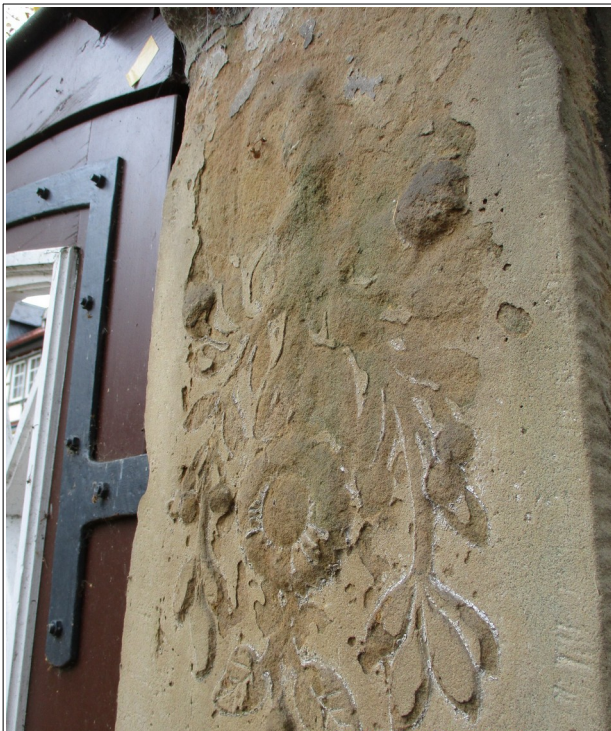
Bild 1: fortschreitende Schäden an den Sandsteinsäulen des Eingangs zum Ulrichschen Garten
